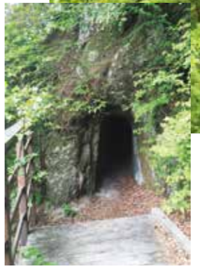
みのり隧道 遊歩道の一部である手掘りのトンネル。天井が低いので腰をかがめて通る。
